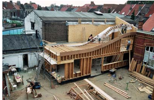
Gebouw in opbouw, bron: PHPvzw, foto: Kobe Wens
