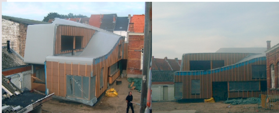
Foto: Einde ruwbouwwerken, zijaanzicht en vooraanzicht, bron: Palladio architecten
